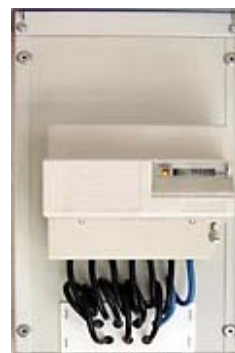
CAJA sin emisor, pero con sistema PLC
